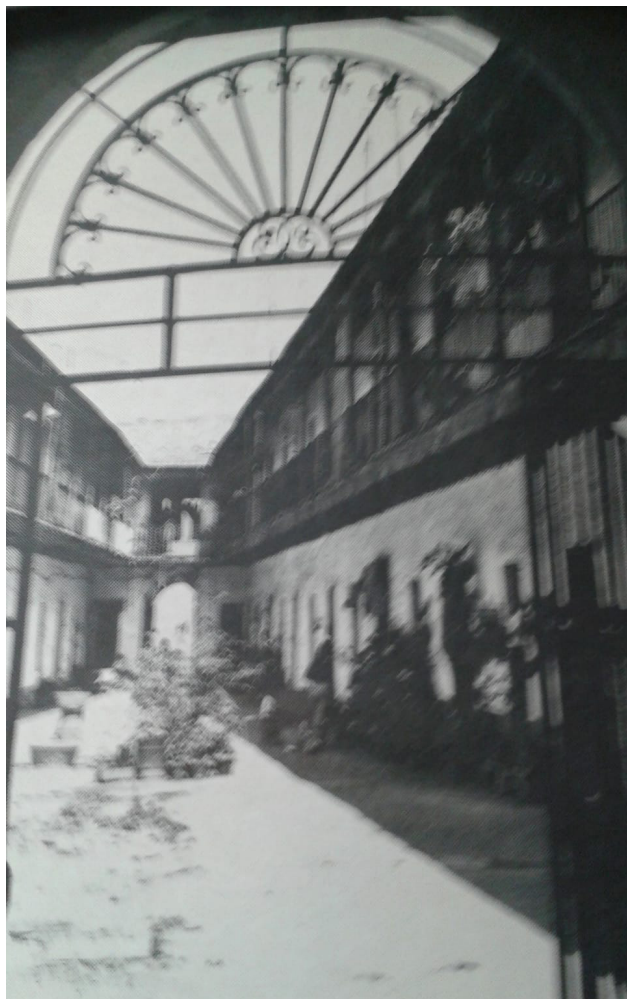
Corral de los Chicharros ya demolido
