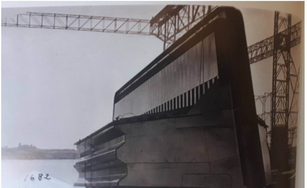
Primera construcción realizada en el astillero sevillano “Barco Puerta Nuestra Señora del Rosario” para dique seco de Astillero de Cádiz
