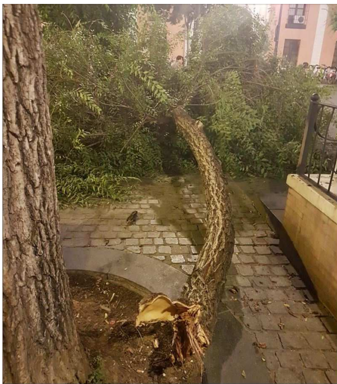
Incidencia por fallo estructural de eje primario de uno de los Ulmus pumila de la plaza del Pumarejo
