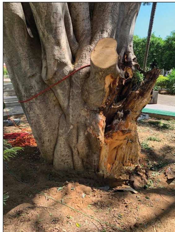
5. Vista del tronco, con daño generado tras el desgarro. Se aprecia también un corte de poda por la eliminación de uno de los ejes que se había visto dañado por la caída del cimbal y estaba afectado por pudrición.
