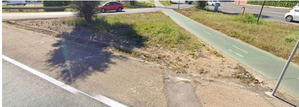
Figura 1. Imagen de cuneta existente y tubo salvacuneta
