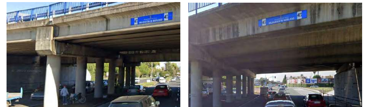
Imagen de las placas que indican el gálibo existente para el cruce bajo la estructura existente
