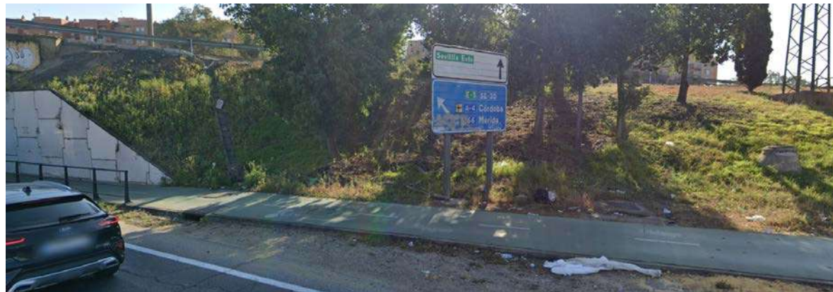
Figura 2. Imagen de bajante en la SE-30
