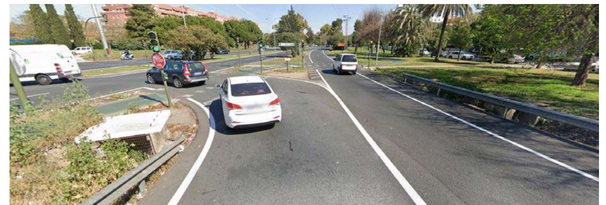
Figura 4. Cuneta existente en ramal de salida de la SE-30 decreciente hacia Sevilla este y arquetas al final de la misma.
