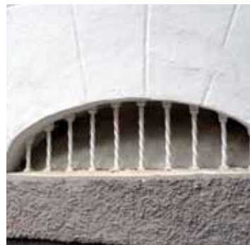
▲ Rejas de ventilación sobre zócalo de revoco a la tirolesa.
