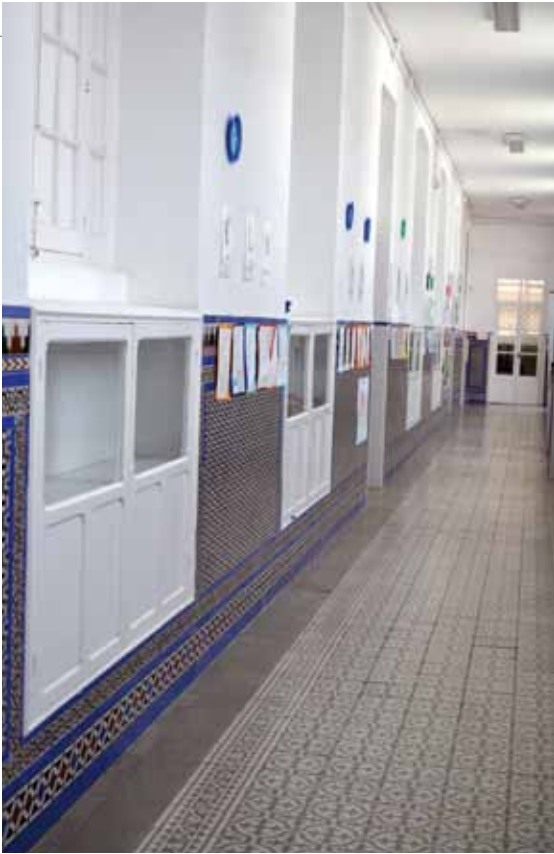
▲ Corredores con vitrinas expositoras. Se puede apreciar las originales baldosas hidráulicas.
