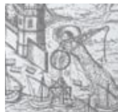
Ilustración: Puerto de Sevilla en el Siglo XVI. Puede observarse claramente la grúa que se instaló para descargar las piedras para la construcción de la catedral
