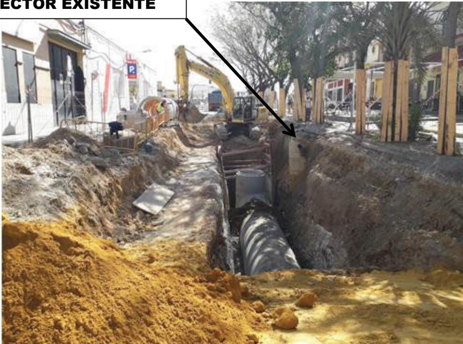
Debido a la profundidad a la que se ha proyectado el nuevo colector (6,5 m en el lugar más desfavorable) la sección excavada tiene que tener bermas intermedias para facilitar el alcance de la maquinaria al fondo de la excavación y por seguridad de los operarios que tienen que transitar por el interior de la zanja. Estos condicionantes, junto con los servicios existentes hacen que el ancho de la zanja en coronación alcance un ancho medio 6 m.
