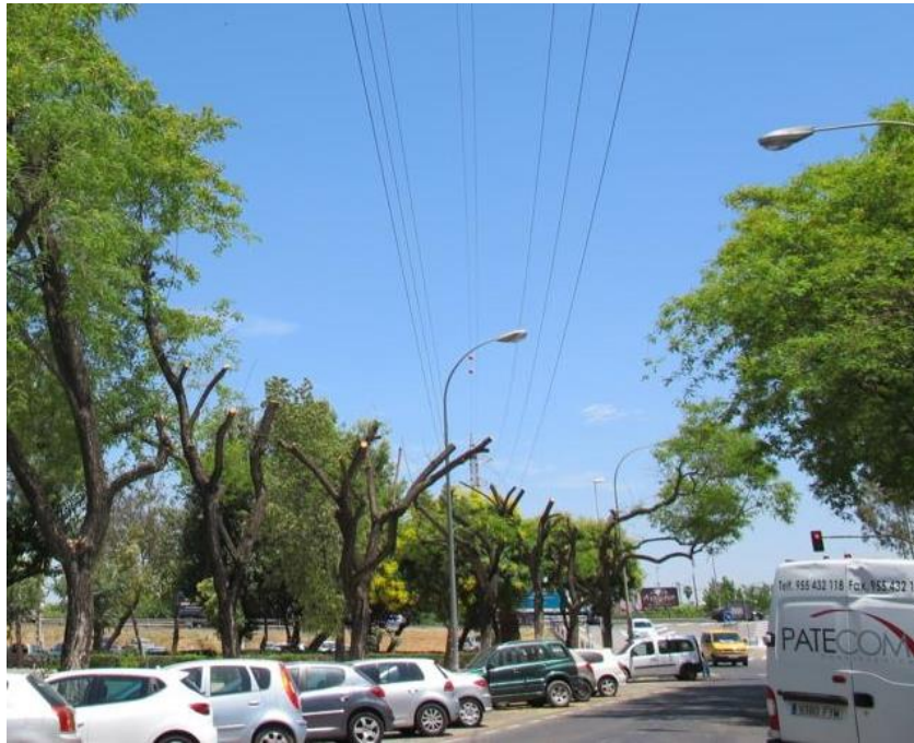
Podas motivadas por la proximidad de la línea eléctrica
