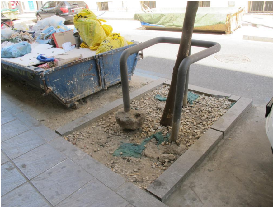
Protector desenterrado por los continuos golpes de vehículos
