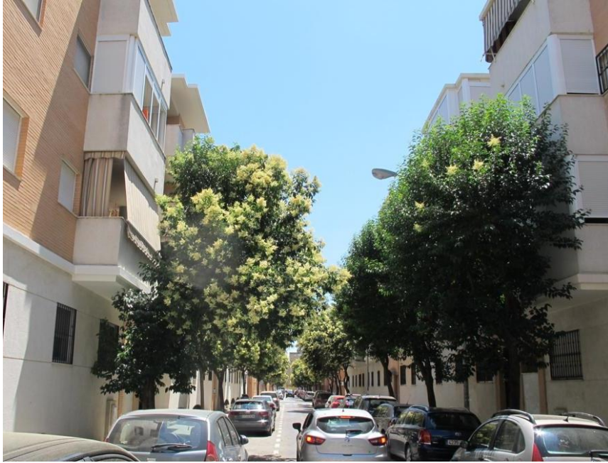
Arbolado excesivamente próximo a fachadas
