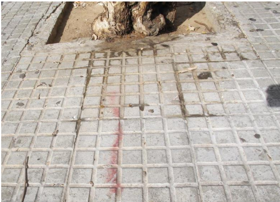
La línea roja indica el paso de la red de alumbrado por el medio del alcorque.
