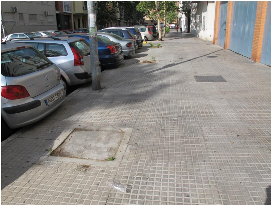
Excesiva cercanía del alcorque a la farola
