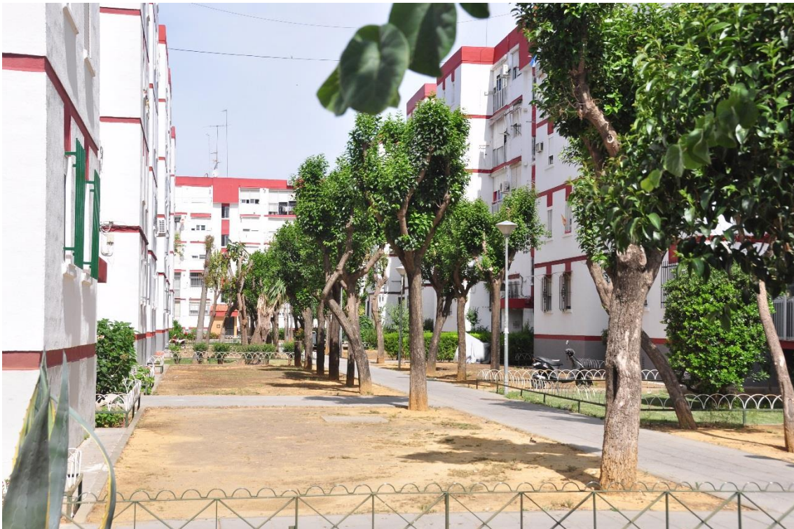
Ejemplo de barriada abierta con arbolado en mal estado
