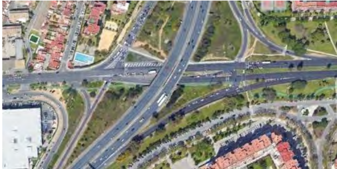
Estado actual de la intersección
