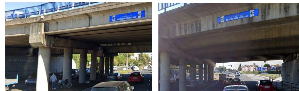
Imagen de las placas que indican el gálibo existente para el cruce bajo la estructura actual
