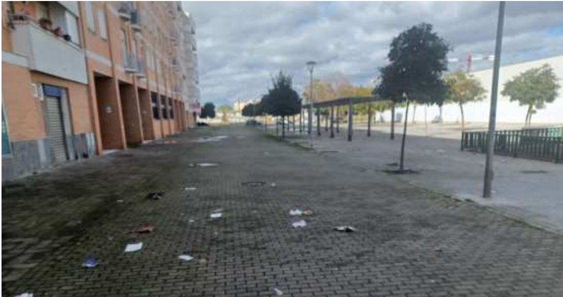
Vista general de la calle y de las estructuras y viviendas.
