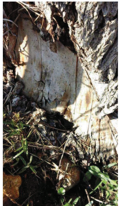
Ampliación de la cavidad en la base del tronco/cuello del árbol en la zona de compresión.
