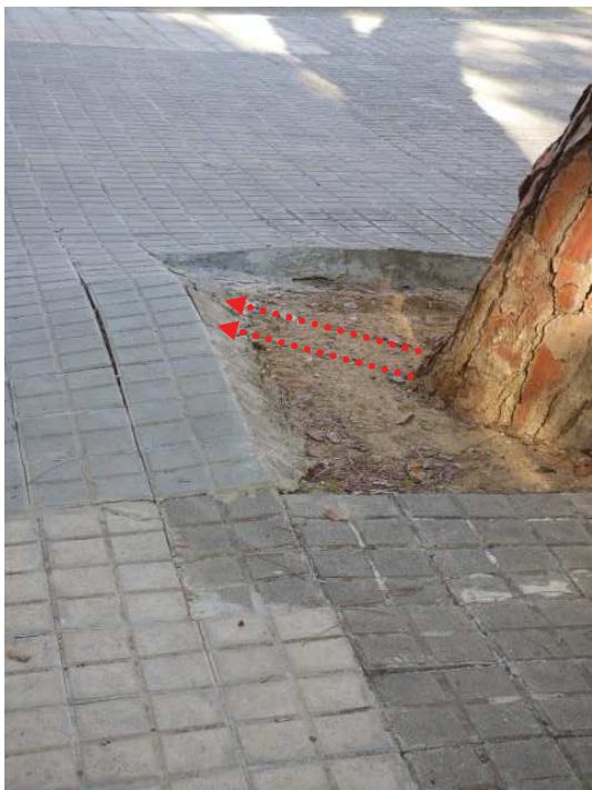
Detalle de levantamiento del pavimento (IZQDA) y de hundimiento del fuste (DCHA)
