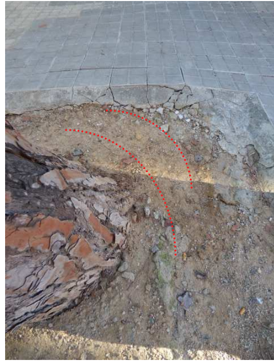
Vista general del árbol e inclinación (IZQDA) y detalle de agrietamiento del terreno (DCHA)
