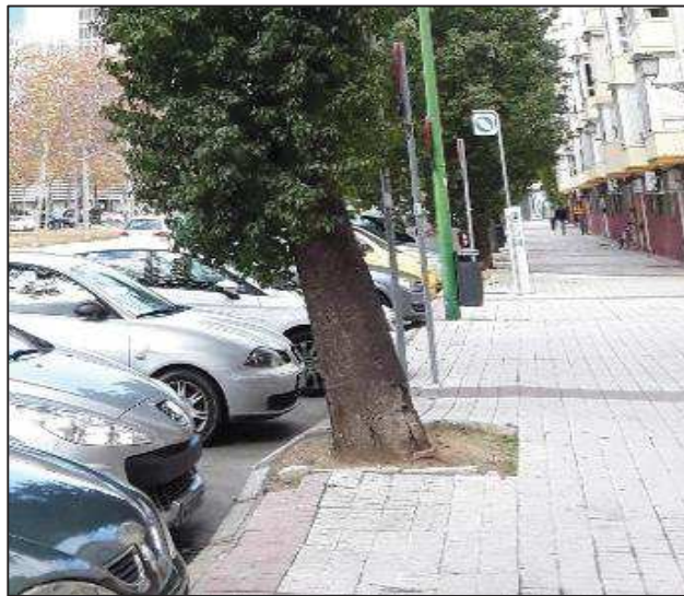
11. Vista alcorque Enero 2019 (Fte. Inspecciones Lote 2)
