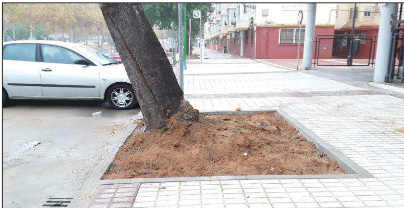
12. Vista alcorque Diciembre 2020 (Fte. Inspecciones Lote 2)
