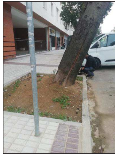
4. Vista de la base. Abultamiento del terreno
