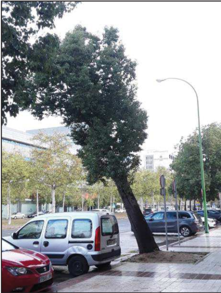
9. Vista detalle inclinación (Fte. Inspecciones Lote 2)
