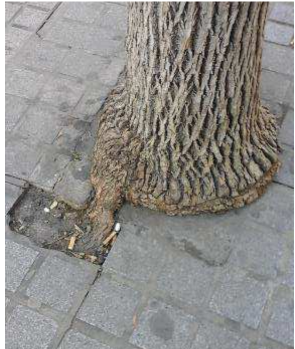
Foto 3. Enero 2023: alcorque cegado con adoquines de granito y cemento: miriñaque -estrangulamiento y posible anoxia radicular. Migración de raíces.
