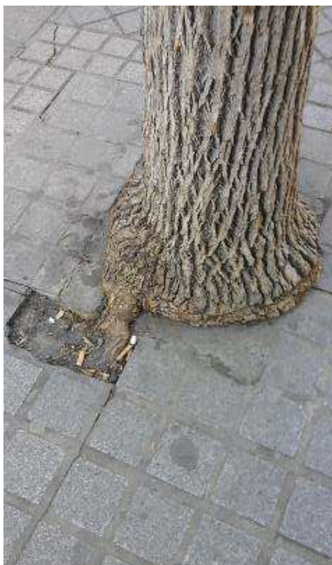
Adoquinamiento y cementación del alcorque: impermeabilización y estrangulamiento del cuello/base del tronco. Formación de mirriñaque y migración de raíces. Posible anoxia y pudrición de cuello.
