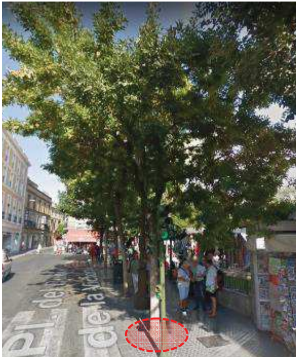
Captura 4. Reducción progresiva del alcorque desde 2012, apareciendo totalmente cegado en agosto del 2016, cuando todavía se aprecia una vegetación aparentemente
