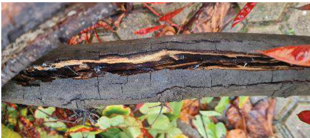
Figura 3: Detalles de grietas de una de las ramas.
